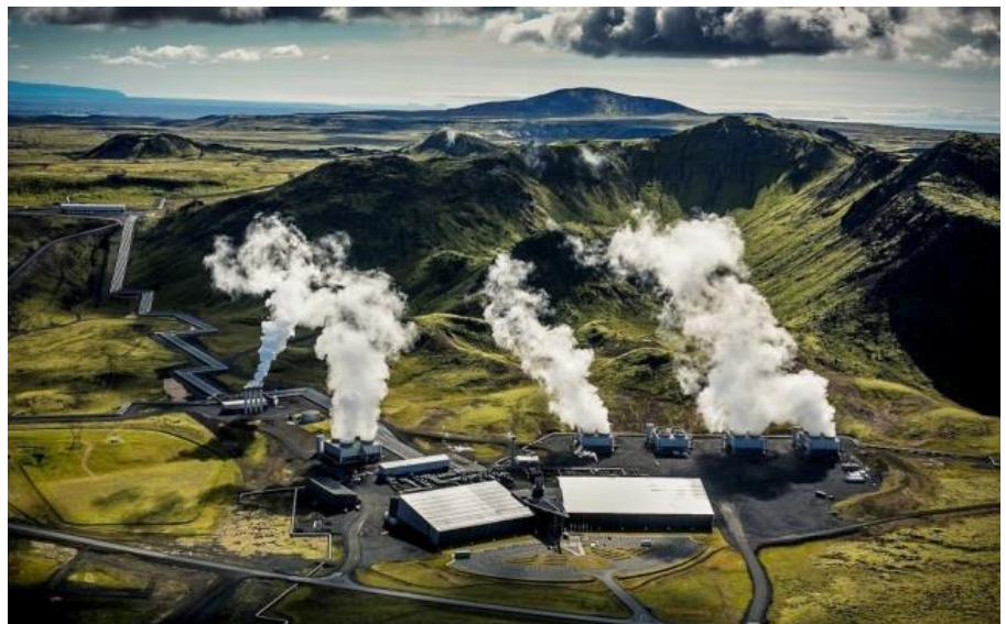
DAC Anlage von Climeworks in Island. (Foto: Árni Sæberg/Helena Group Wikimedia)
